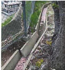
① 126 棟南側 U 字溝破損
